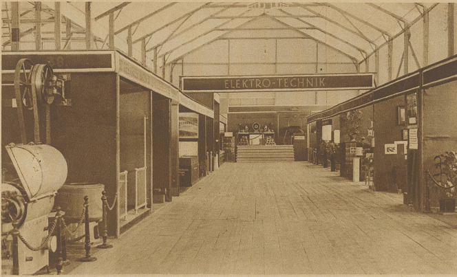
Blick in die Abteilung Elektro-Technik
