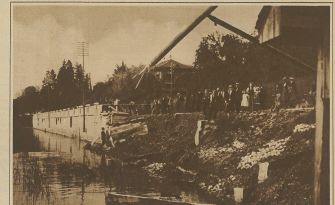
Die eingestürzte Seemauer bei Zug
