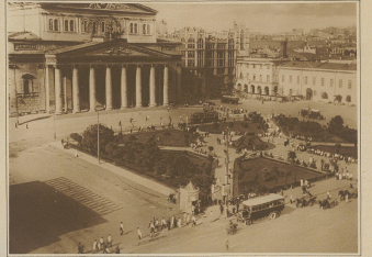
Das neue Moskau. Linere Aufnahmen zeigen den Theaterplatz mit einigen modernen Ausbauten die dieser Lage dem Verkehr übergeben werden
