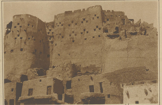
Der Häuserwall der alten Stadt. Aus Platzmangel bauten die jungen Generationen auf die Wohnungen der ältern
