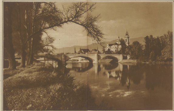
Die neue Rotbrücke in Solothurn. Sie wurde als Notstandsarbeit mit einem Kostenaufwand von 1,300,000 Franken ausgeführt
