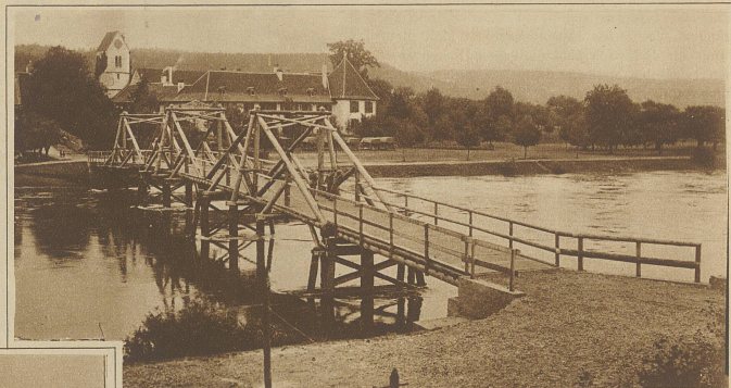
Die fertige Brücke über den Nidau-Büren-Kanal
