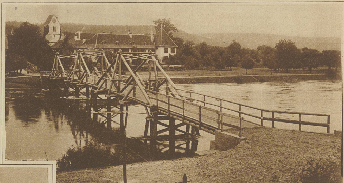
Die fertige Brücke über den Nidau-Büren-Kanal
