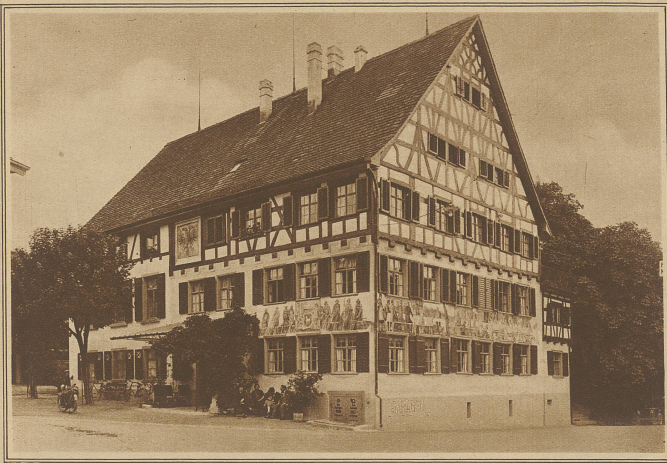
Der renovierte Gasthof zum «Adler» in Ermatingen
