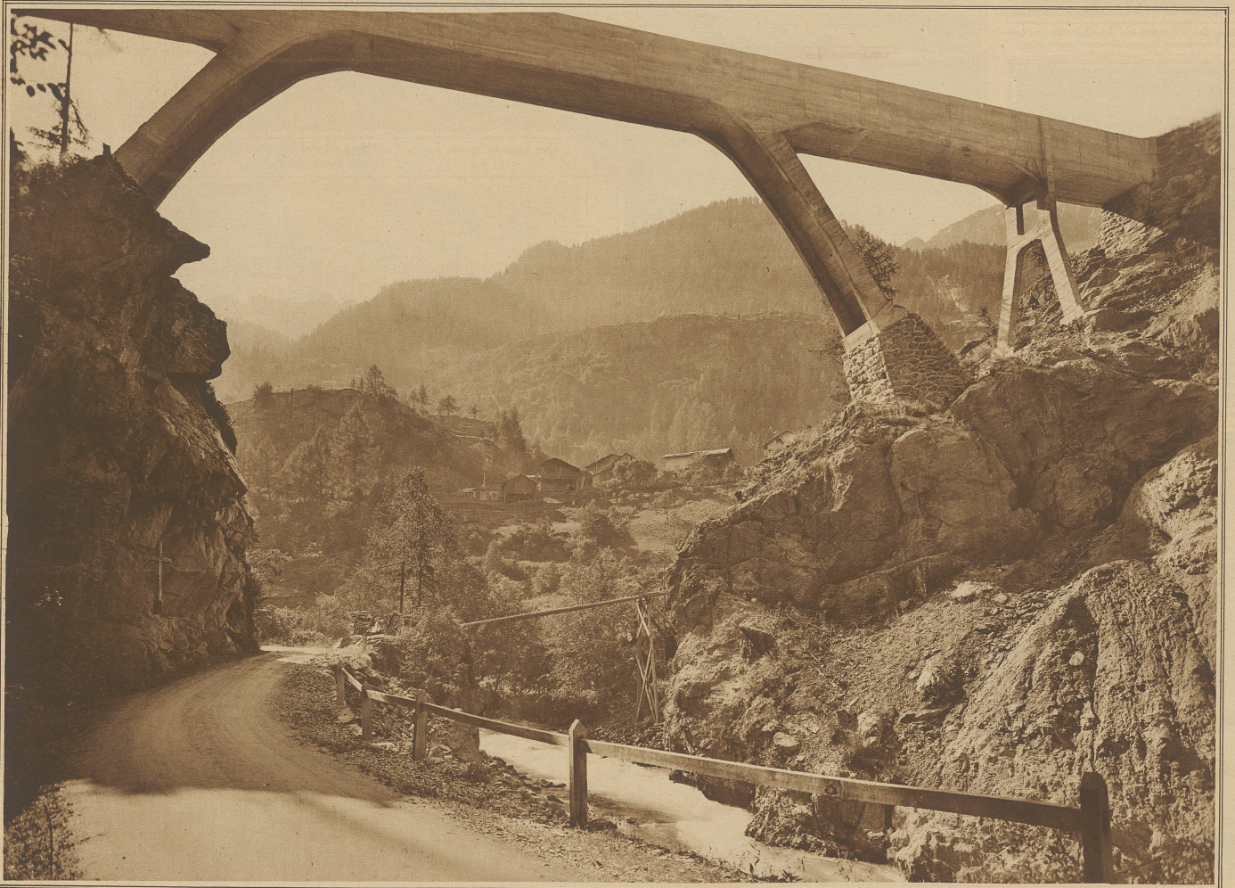
AQUÄDUKT IN CHÂTELARD / ZULEITUNG DER EAU NOIR INS KRAFTWERK VERNAYAZ
