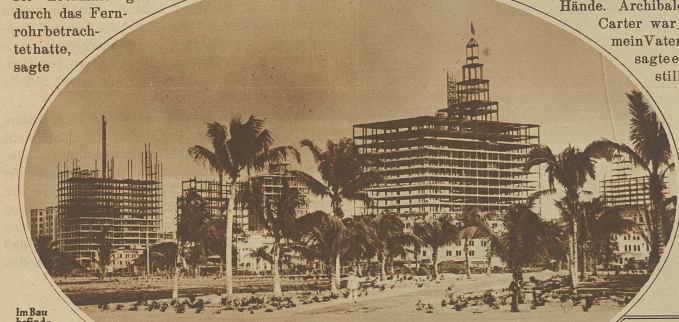
Im Bau befindliche Hotels in Miami. Man beachte die eigenartigen Orterte, die es erlauben, den Bau nicht nur vom Fundament aus, sondern auch in oberen Stockwerken zu beginnen.
