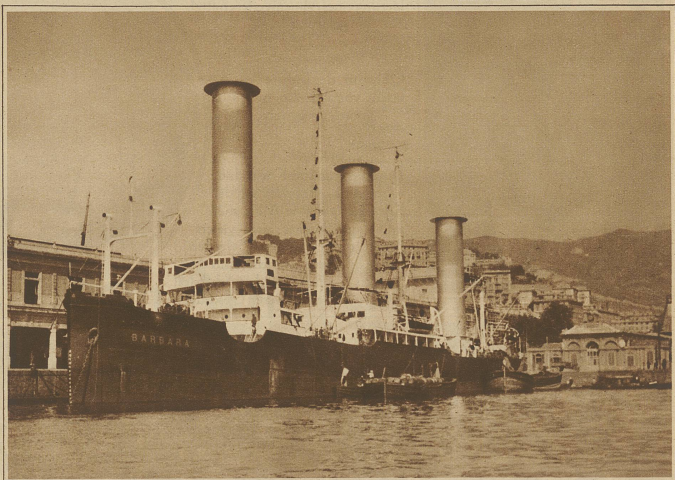
Das größte bis jetzt gebaute Rotorschiff «Barbara», das einzig von der Kraft des Windes getrieben, von Spanien kommend, im Hafen von Genua einlief
