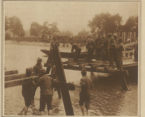
Pontoniere beim Brückenschlag über die Reuß zwischen Bremgarten und Eggenwil
