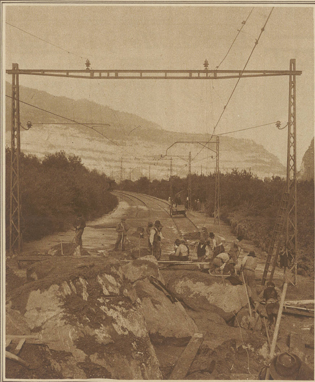
Räumungsarbeiten auf der mit großen Felsblöcken übersäten Simplonlinie der Schweizerischen Bundesbahnen
