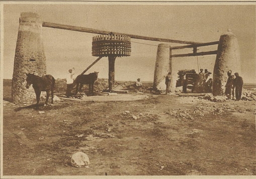
Eine eigenartige Brunnenanlage auf einem jüdischen Siedlungsgelände in Südrussland. Das Pferd treibt die senkrecht stehende Welle und hebt dadurch den großen Wassereimer aus dem 80 Meter tiefen Sock
