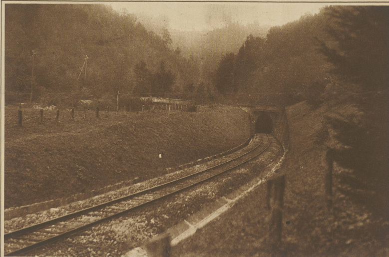
Blick auf den Eingang zum Ricken-tunnel auf der Kaltbrunner Seite, wo der bei Kilometer 4 stecken gebliebene Unglückszug einfuhr
