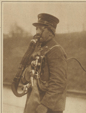
Ein Streckenwärter mit dem Sauerstoffapparat, wie er bei der ersten Rettungsaktion leider erfolglos zur Verwendung gelangte
