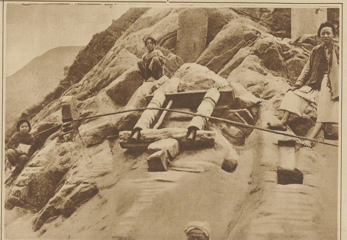
An einer Felsenecke: Das Treidelseil hat in der jahrhundertelangen Arbeit tiefe Rillen in den Fels geschliffen
