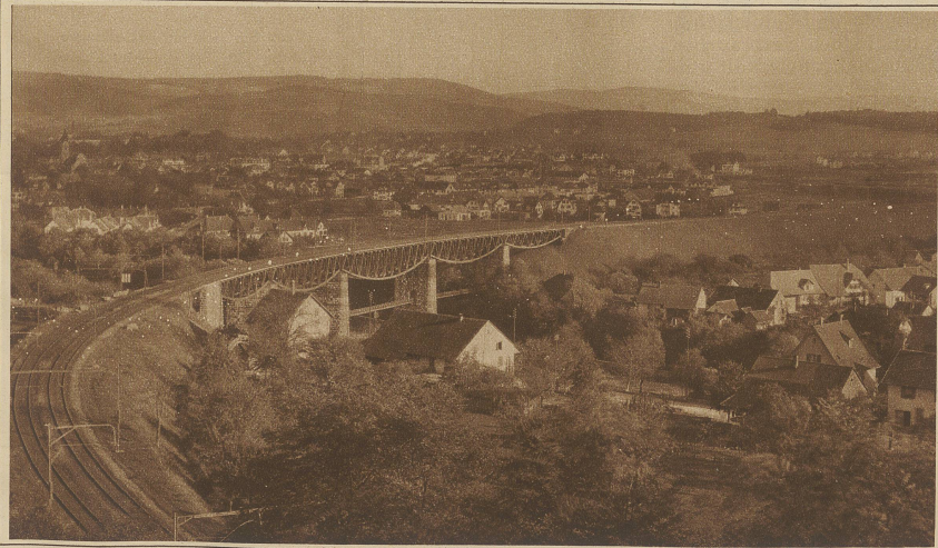
Blick auf die für die elektrische Traktion verstärkte Aarebrücke bei Brugg
