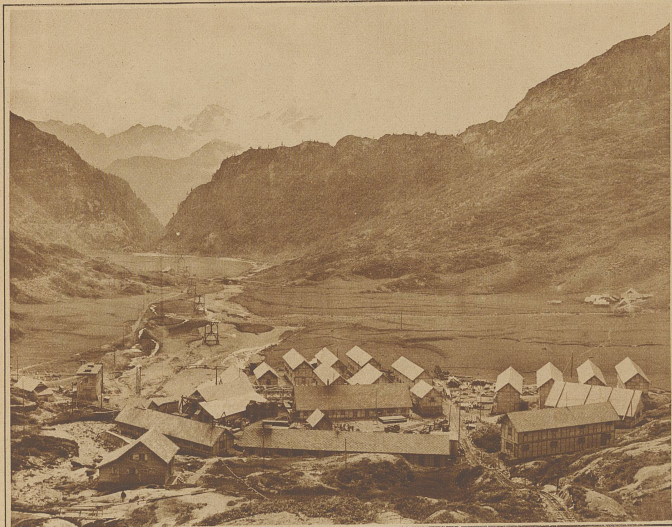
Emmosson und die Baubarracken, von der Stauwand aus gesehen
