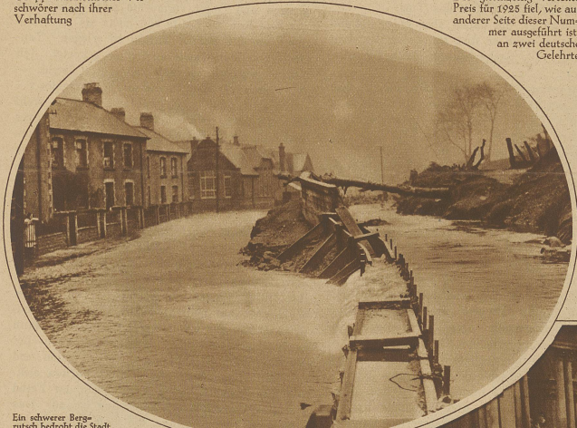
Ein schwerer Bergsturz bedroht die Stadt Cwm in Wales. Hunderttausende von Kubikmetern Erde sind in Bewegung geraten, so daß die untersten Teile des Rutschgebietes, wie in unserem Bilde ersichtlich, schon die ersten Häuser erreicht und durch Abdrängen eines Flußlaufes große Überschwemmungen verursacht haben
