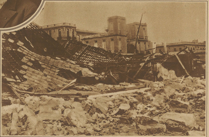
Ein Fabrikgebäude in Havanna, dessen mächtige Eisenkonstruktion durch den Sturm zum Einsturz gebracht wurde
