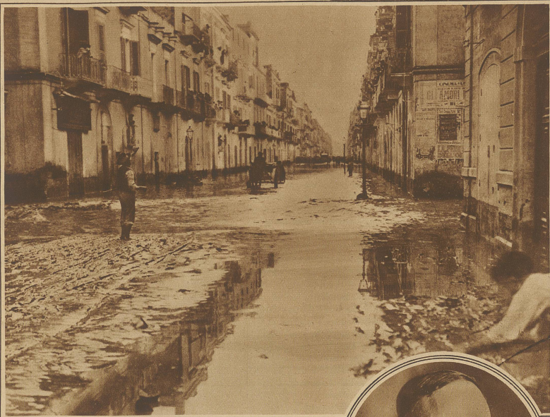
Zur Unwetterkatastrophe in Bari. Blick in eine der von Schlamm und Schmutz strohenden Straßen nach Abzug des Hochwassers
