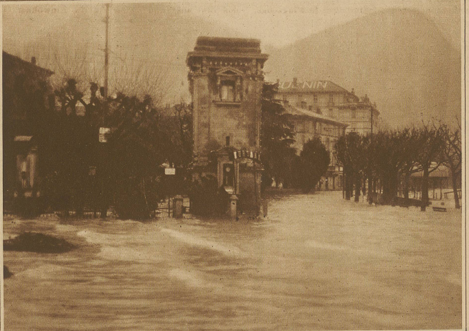
Die vom Sturmwind gepölschten Fluten des Hochwassers, das letzte Woche wieder späten Schaden in den Seegemeinden des Kantons Tessin anrichtete, überschwemmen den öffentlichen Park in Lugano Phot. Auditor
