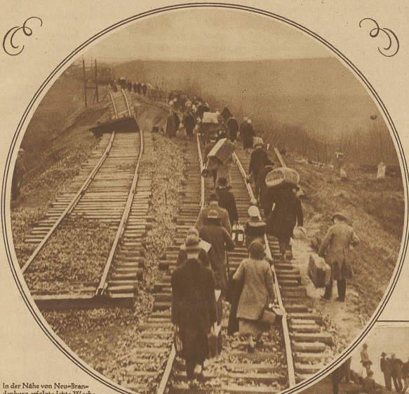
In der Nähe von Neu-Brandenburg erfolgte letzte Woche ein Dammbruch der Bahnlinie nach Passau. Menschenleben sind keine zu beklagen, da der fällige Personenzug glücklicherweise rechtzeitig aufgehalten werden konnte. Wie unser Bild zeigt, wird der Verkehr durch Umsteigen aufrecht erhalten
