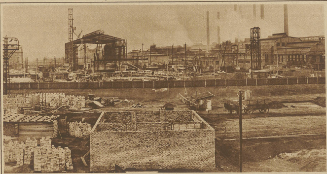
Die Fabrik zur Kohlen-Verflüssigung. Ein Werk von gigantischen Ausmaßen ist in Leuna bei Leipzig im Entstehen begriffen; die erste Fabrik zur Verflüssigung der Kohle. Das Werk soll nach seiner Fertigstellung in der Lage sein, jährlich 120 Millionen Tonnen Benzin zu erzeugen. Unser Bild zeigt die Neubauten der in Entstehung begriffenen Fabrik
