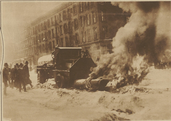
Die südlichen Gebiete der U. S. A. sind von einem schweren Schneesturm heimgesucht worden. In New York allein waren 20000 Arbeiter mit Schneeschaukeln beschäftigt. Wie unser Bild zeigt, kamen außerdem besondere Schneeschmelzmotoren zur Verwendung, die den auf Mahden gehäuften Schnee in den Hauptverkehrsadern künstlich sehr rasch zur Schmelze bringen
