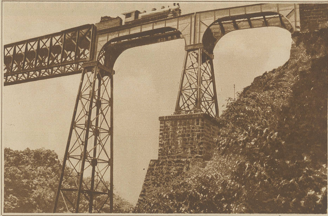
Ein Viadukt im brasilianischen Hochland
