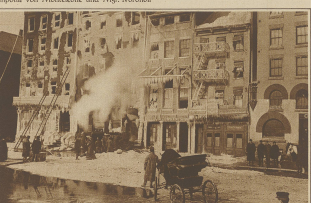
Schwerer Brandstichtungs. Vereinte Häuserfronten bei der Löschung eines Brandes in einem Außenquartier von New York.
