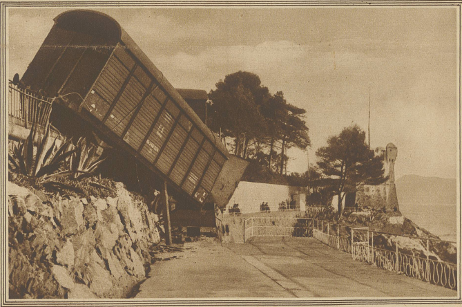
Ein entgleister Güterwagen auf der Strandpromenade in Nervi. Der Wagen rutschte über die Böschung hinunter und blieb quer über der Promenade hängen
