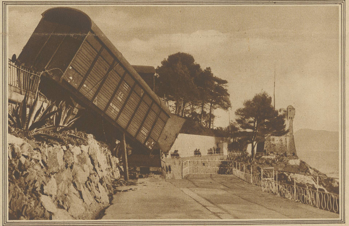
Ein entgleister Güterwagen auf der Strandpromenade in Nervi. Der Wagen rutschte über die Böschung hinunter und blieb quer über der Promenade hängen
