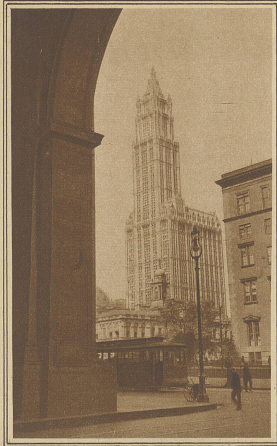
Das 52 Stockwerke hohe Woolworth-Gebäude
