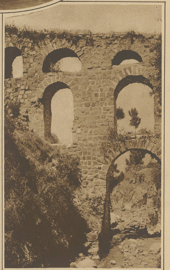
Ein Ausschnitt aus der alten, über 600 km langen Bewässerungsleitung, die stellenweise über tiefe Talschnitte geführt wurde
