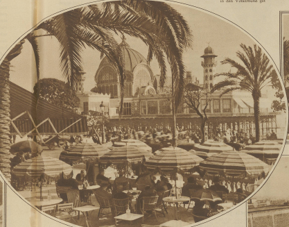
Blick von der Terrasse eines Hotels auf die Nizzaer-Jette
