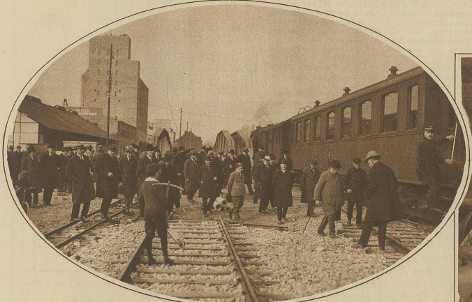
Der erste aus dem neuen Hafenbahnhof Kleinhüningen ausfahrende Personenzug (S. B. B.) führt die Teilnehmer durch die ausgedehnten Basler Bahnhofanlagen
