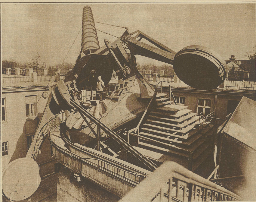
Einstellung des Fernrohres. Rechts und links die großen Gegengewichte. Diese Art der Konstruktion erlaubt die Legung des Objektivs in den Drehpunkt, so daß der Beobachter auch bei großen Richtungsänderungen seinen Standort nicht zu verlassen braucht
