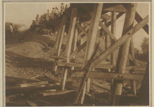
Die wieder hergestellte Eisenbahnbrücke aus Holz, die von Banditen angezündet wurde und beim Herannahen unseres Zuges in hellen Flammen stand
