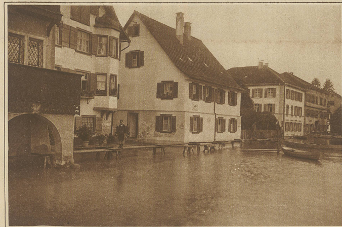
Hochwasser in Gottlieben
