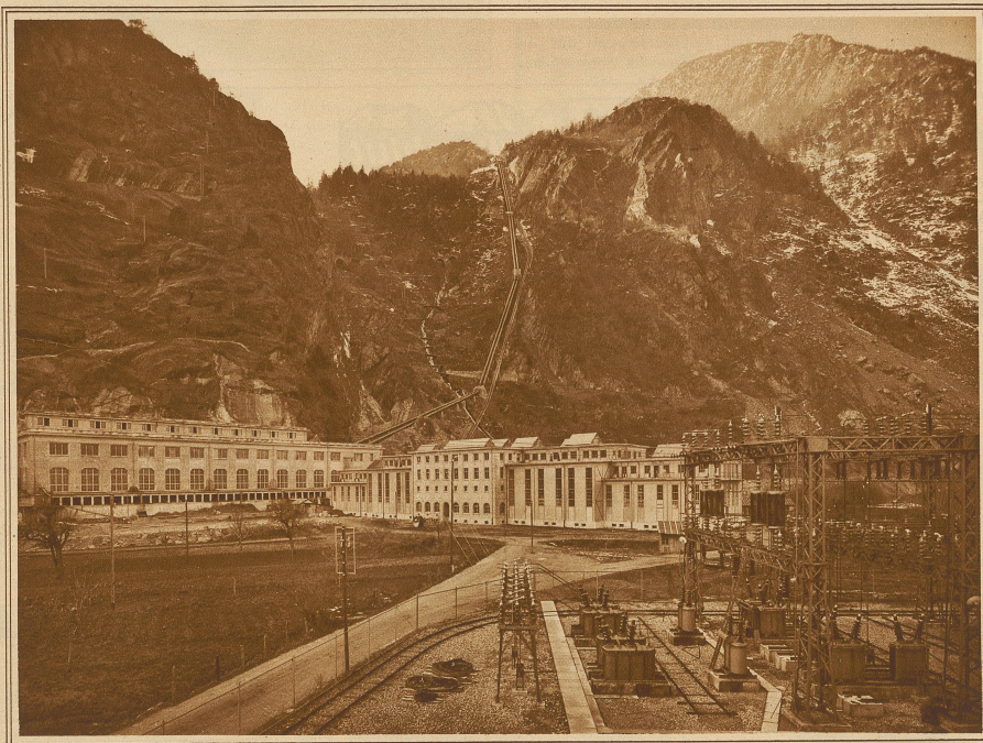
Blick auf das nun vollendete Kraftwerk Vernayaz der Schweiz. Bundesbahnen Der Höhenunterschied vom Wasserschloß in Salvan bis zur Zentrale beträgt 650 m
