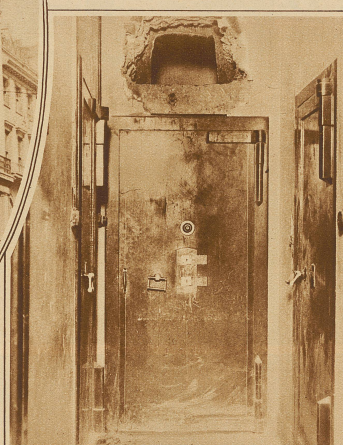
Ein aufgesprengter Safe im Keller des Gebäudes
