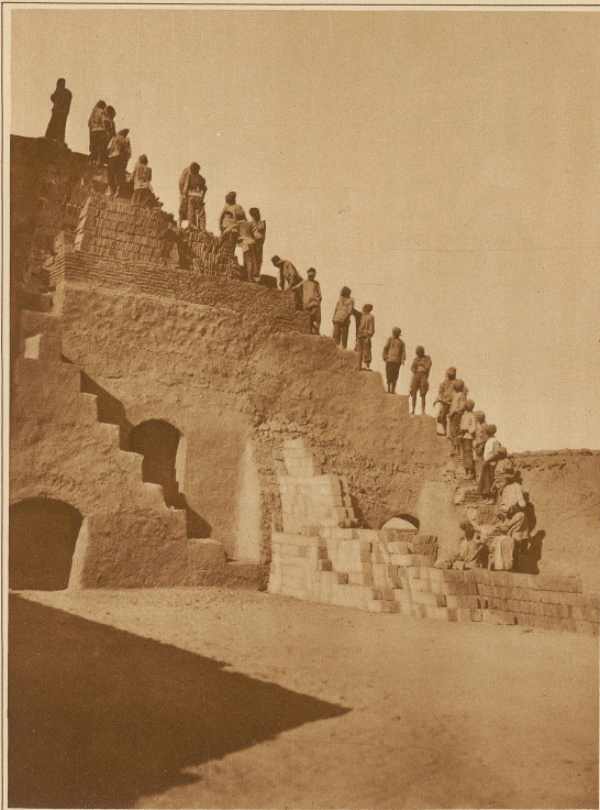
Eine Kette von Arbeitern reicht sich die Ziegel
