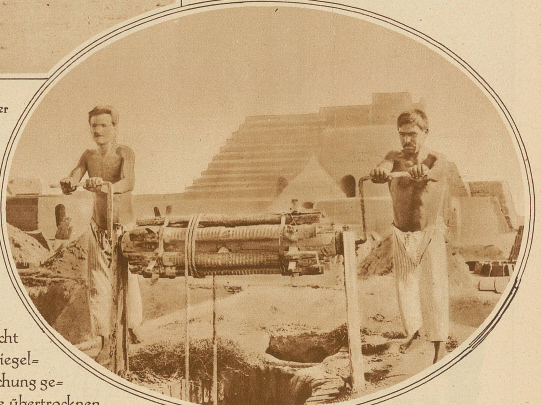
Das Wasser wird auf primitive Art aus dem Sodbrunnen geschöpft die das einzige Wahrzeichen der einst hoch-stehenden persischen Baukunst sind.
