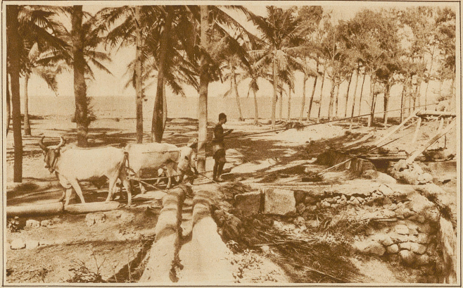
Bewässerung einer Cocos-Plantage in Porbandar-State, Kathiawar
