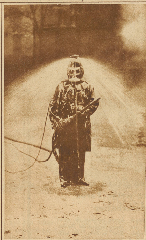
Eine neue Schutzvorrichtung für Feuerwehrlente, die es ermöglichen soll, auch bei größter Hitze den Brand aus nächster Nähe zu bekämpfen
