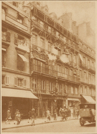
Die Fassadenreinigung durch Dampf ist eine der neuesten Erfindungen, die gegenwärtig in Paris mit gutem Erfolge ausprobiert wird. Der Dampf strömt unter Druck aus einem schmalen Schlitz und entfernt so allen Staub und Schmutz von der Oberfläche der Steine
