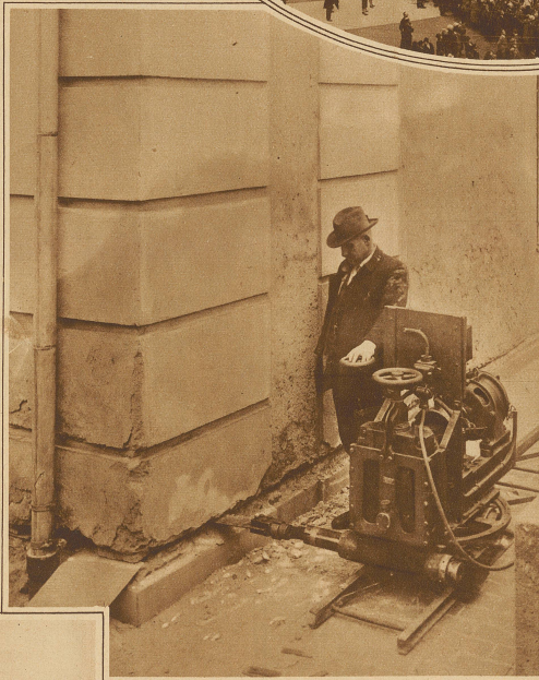
Die neueste Errungenschaft auf dem Gebiete der Technik ist die von einem Münchner Baumeister erfundene elektrische Mäuersäge, die dazu dient, Wasser ziehendes, durchfeuchtetes Mauerwerk zu ebener Erde durchzuschneiden, so daß in die Schnittfuge eine Isoliermasse eingegossen werden kann. Auf diese Weise können Häuser, ohne Belästigung der Bewohner, vor dem Hausschwamm gesichert werden
