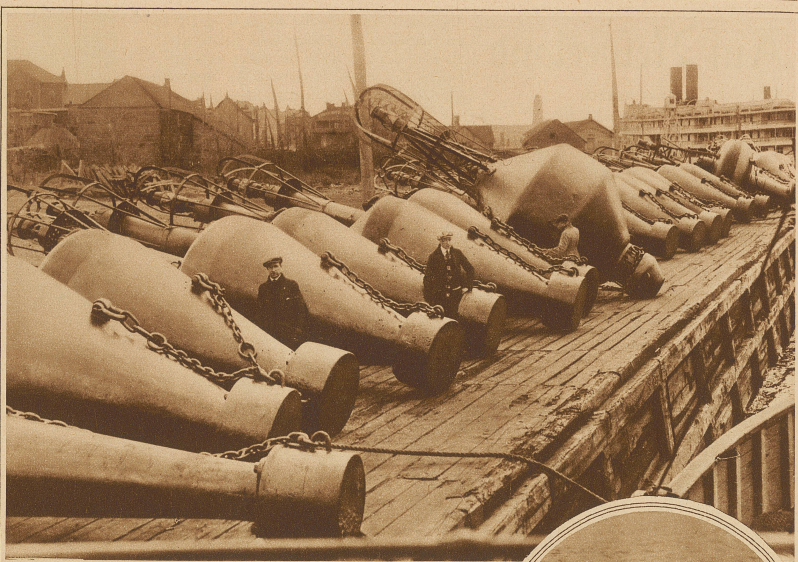
Gewaltige schwimmende Leuchtbojen, die den Kurs auf dem St. Lawrencefluß anzeigen. Diese Bojen werden zur Winterzeit heraufgezogen und zu Beginn der Schifffahrt wieder versenkt
