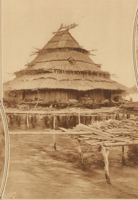
Das Versammlungs- und Kulthaus in einer Siedlung der Humboldt-Bai (Holl. Neuguinea). Das abgestuften, mit Atap gedeckte Dach ist auf originellste Weise mit hölzernen Fischen, Schlangem, Eidechsen und anderen Tieren besetzt
