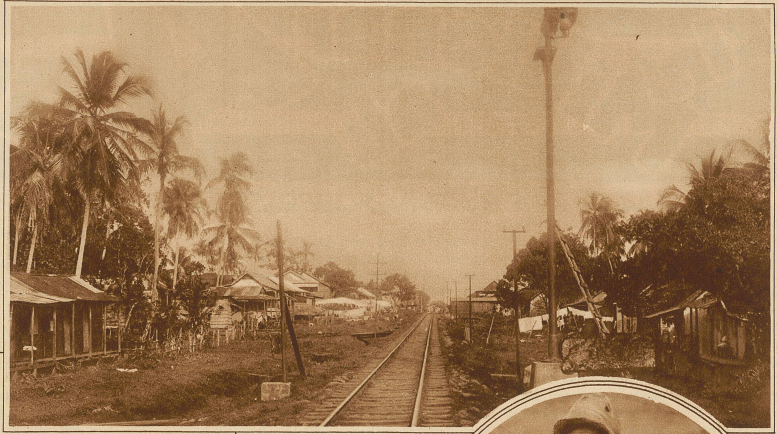
Der Eisenbahnlinie entlang aufgestellte Negerhütten
