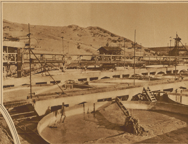
Das diamanthaltige Gestein wird in große Schwemmbehälter gebracht
