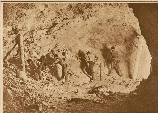
Vorbereitungen für eine Sprengung
