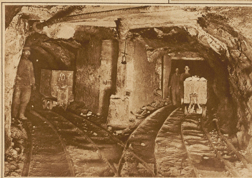
Soweit Förderkarren vorhanden sind, müssen sie in den Stollen durch einzelne Arbeiter geschoben werden
