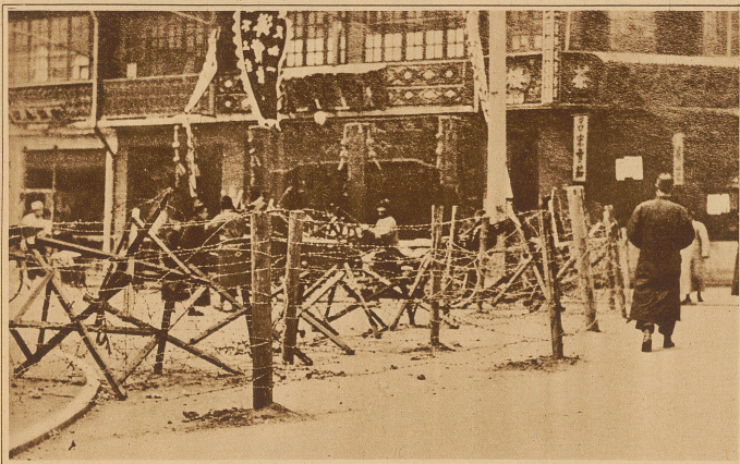
Durch Drahtverhaue abgesperrte Straßen im Europäerviertel in Schanghai ZUR VERSCHÄRFUNG DER LAGE IN CHINA
