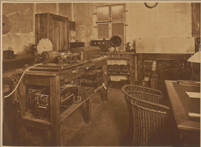
Blick in den Bildsenderraum der Station Nauen
