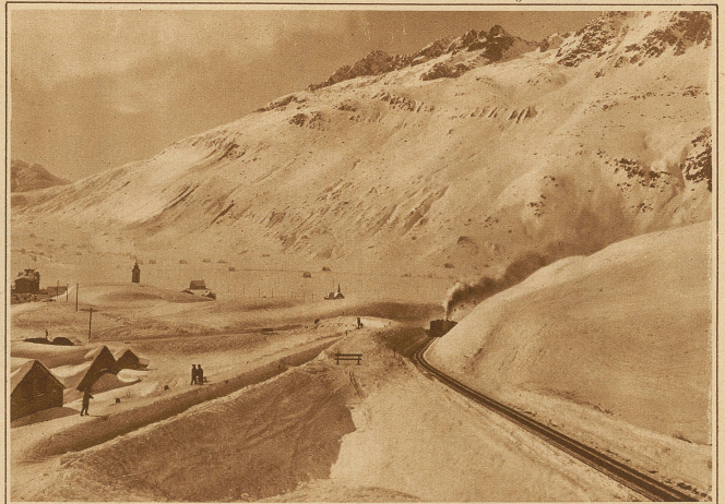
Auch die Oberalpbahn machte diesen Winter erfolgreiche Versuche zur Einführung von Sportzügen in die Skifelder oberhalb Andermatts. Unser Bild zeigt einen Zug auf der Talfahrt. Im Hintergrund der durch seine Fortifikationen bekannte Bälberg Phot. Culler
