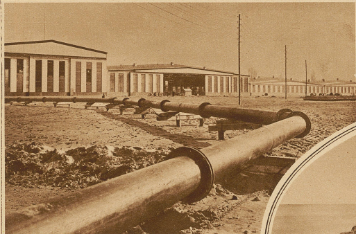
Blick auf die Flughallen. Im Vordergrund ein Teilstück der 1000 Meter langen Röhrenleitung, durch welche der Seeschlamm auf das Flugfeld geschwemmt wird
