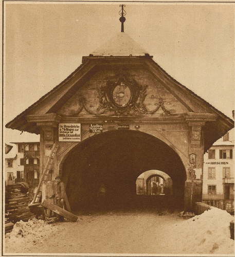
Eingang zur alten Mellinger Reußbrücke
