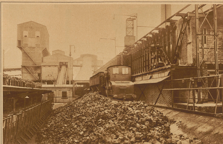
Die Koksseite einer großen Ofenanlage auf der Zeche Scholven in Zweckel
