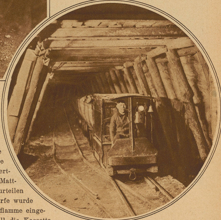
Stollengang mit elektrischer Lokomotive
