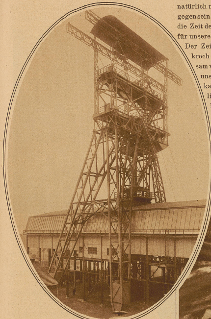
Fördergerüst auf der Krupp'schen Zeche Hannover III/IV in Hordel in Westf.
