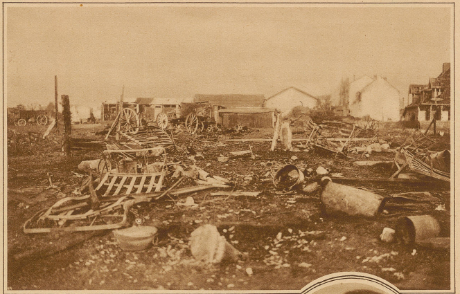
Bei Bailleul (Nordfrankreich) ereignete sich infolge Ausbruches einer Feuersbrunst in einer Baracke eine schwere Explosion in einem Granatnagelager. Etwa 20 Häuser wurden zerstört und 7 Personen schwer verletzt. Blick auf das Trümmerfeld nach der Explosion
