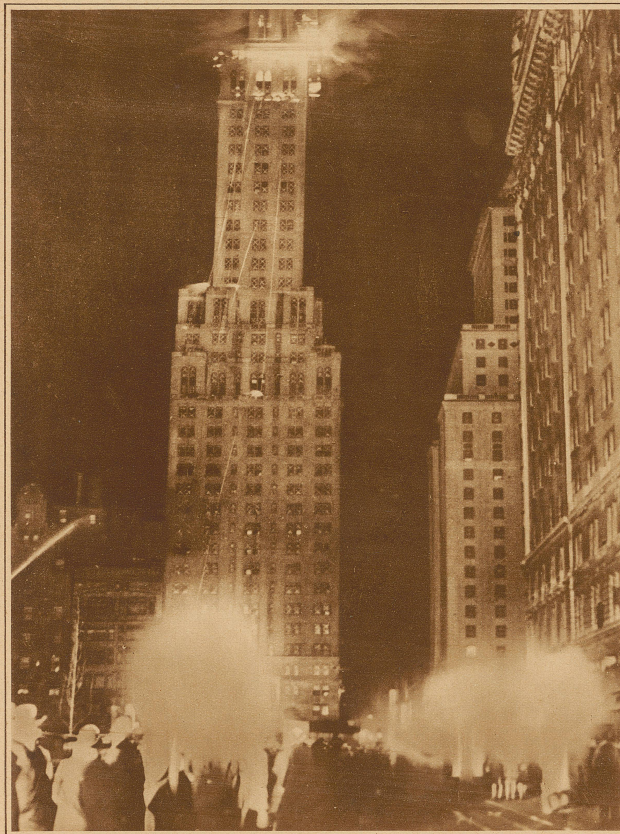
Großer Wolkenkratzerbrand in New York. Während einer ganzen Nacht leuchtete die Riesenackel des brennenden Hotels „Niederland“ über das Häusermeer New Yorks. Der am Kreuzungspunkt der 5. Avenue mit der 59. Straße, also im belebtesten Zentrum gelegene Bau, der in wenigen Wochen eröffnet werden sollte, brannte vom 38. bis auf das 20. Stockwerk hinunter vollständig aus. Da die Brandstätte ihrer großen Höhe wegen mit den Feuerspritzen bei weitem nicht erreicht werden konnte, stand die Feuerwehr vor einem unlösbaren Problem, das den New-Yorkern für die Zukunft noch große Sorge bereitet
